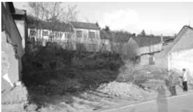
Demolice domu č. 68
